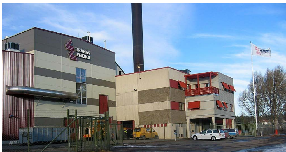
Tranås Energis kraftvärmeverk som producerar fjärrvärme och el.
